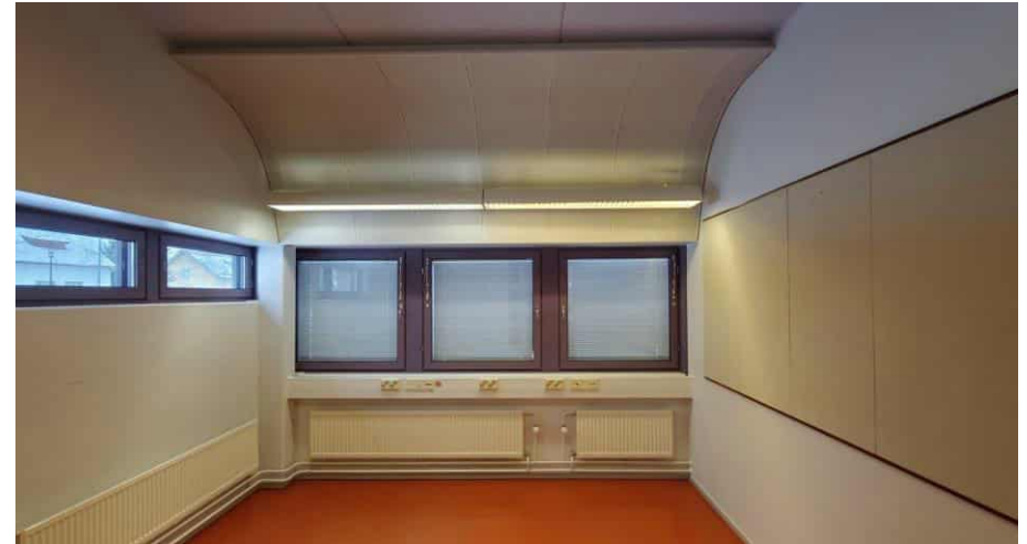
Kuva 53. Rakennuksen luoteiskulman tila A106 sisäpihan puolella. Ikkunatyypit ja kaarevat alumiinikasetit ovat tilatyypille ominaisia.
