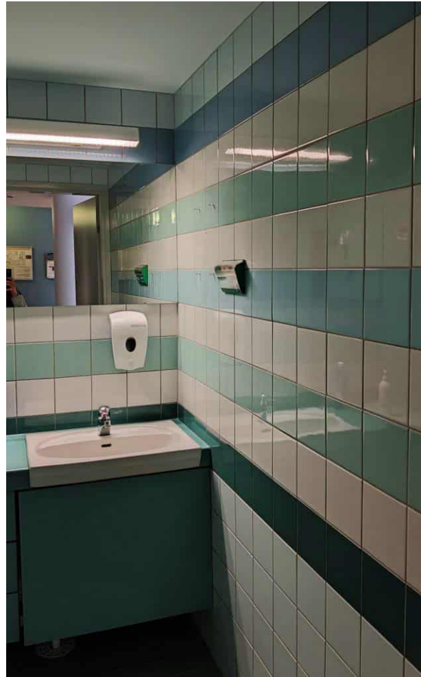
Kuva 70. WC-tila C224, joka on todennäköisesti alkuperäisessä kunnossaan. Moniväriset seinälaatat on käytetty muissakin WC-tilojen laatoituksessa. Lattialaattana on sinivihreä 10x10 cm laatta.
