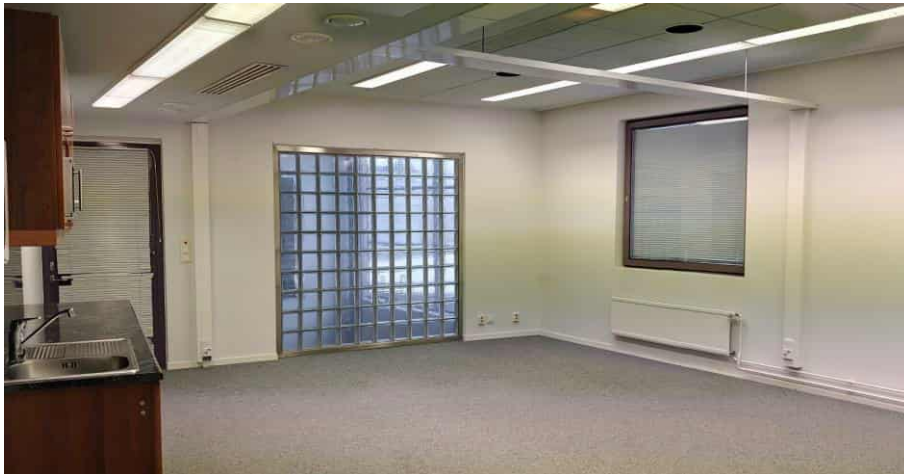
Kuva 52. Neuvotteluhuone B333, jossa tilapinnat (lattiamatto, alakatto) ja kalustus on todennäköisesti uusittu.
