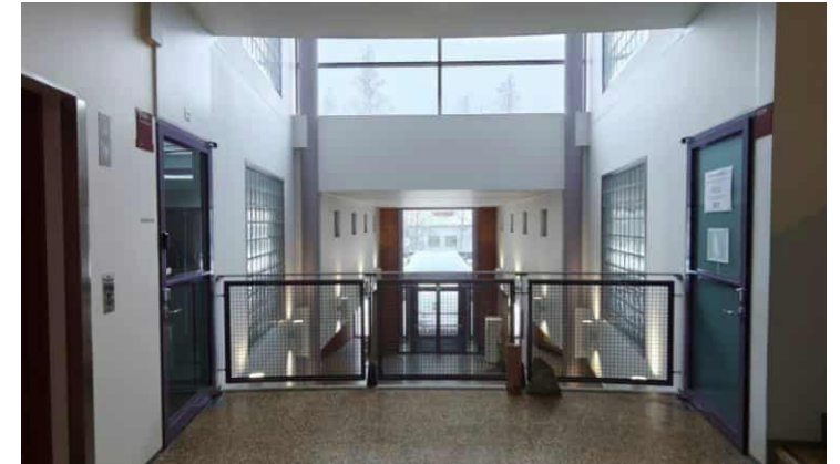
Kuva 74. Toisen kerroksen kerrostasanne pääportaan kohdalla, jossa on metalliverkkokaide. Pääportaita pitkin pääsee kellariin ja johtokunnan saunaosastoon.
