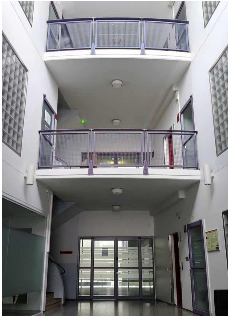
Kuva 49. Aulan päädyssä sijaitsevat pääporras (vasemmalla) ja hissi (oikealla). Näköyhteys ylempiin kerroksiin on mahdollinen kunkin tason leveiden kerrostasanteiden ansiosta.
